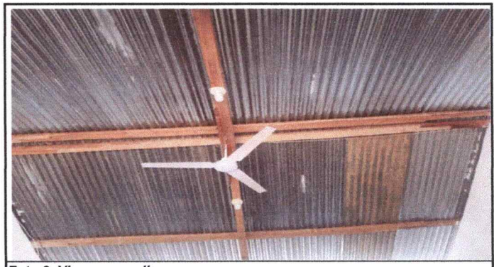
Foto 6: Vigas con polia
